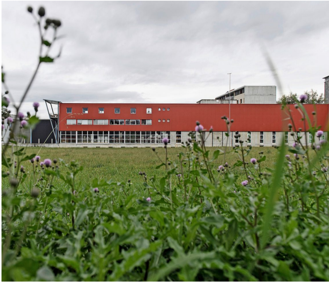
Auf der grünen Wiese in der Buchmatt in Burgdorf wird die Asic Robotics AG ein neues Produktions- und Bürogebäude bauen. Foto: Raphael Moser
