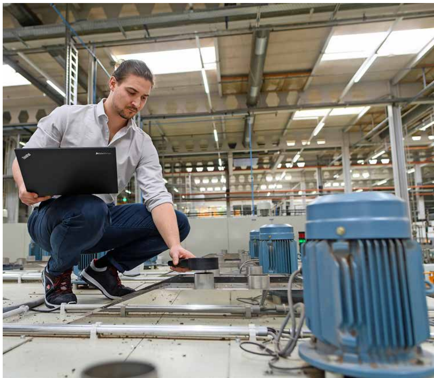
Lucas Struchen, étudiant à la Haute Ecole d'ingénierie et d'architecture de Fribourg, a procédé aux analyses qui ont permis d'apporter des modifications pour une consommation d'énergie réduite de 40%. Alain Wicht
